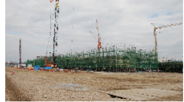
南西側から見た校舎と運動場
