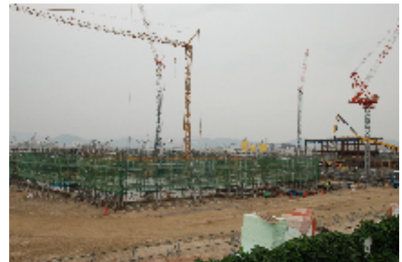
東側からの眺望（手前は東校舎普通教室棟）
