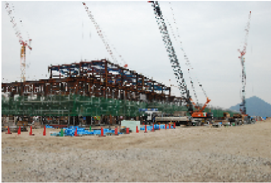
北西から見た校舎
