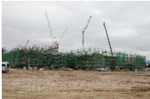
運動場側から見た校舎
