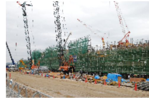
南西から見た西棟校舎
