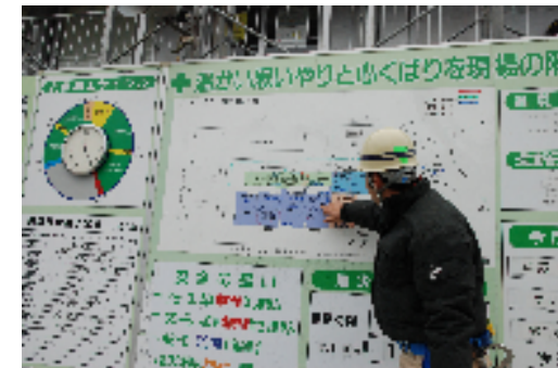
工事の進捗状況を説明していただきました
