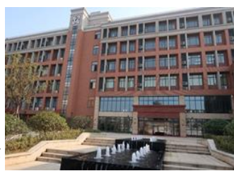
近代的な校舎と設備でした。
