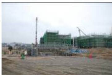
園芸倉庫の基礎工事（南側から）
