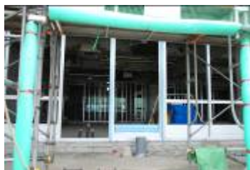
窓枠が付けられた教室
