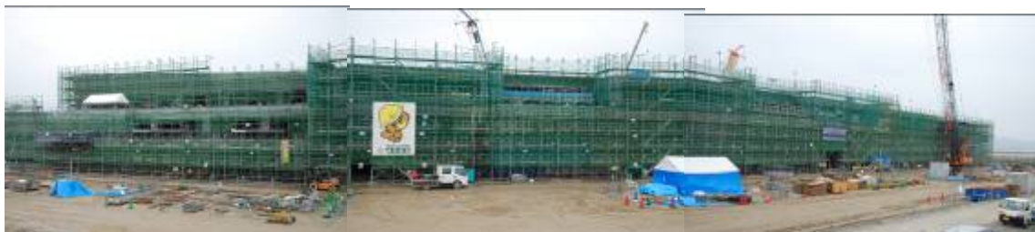
校舎全景（北西から）
