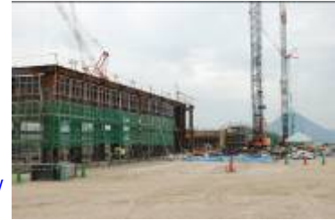
着々と進む新校舎工事
